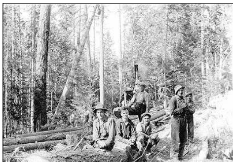
Loading Crew with Gin pole—Camp 2 1922 AV Museum PN 07380
