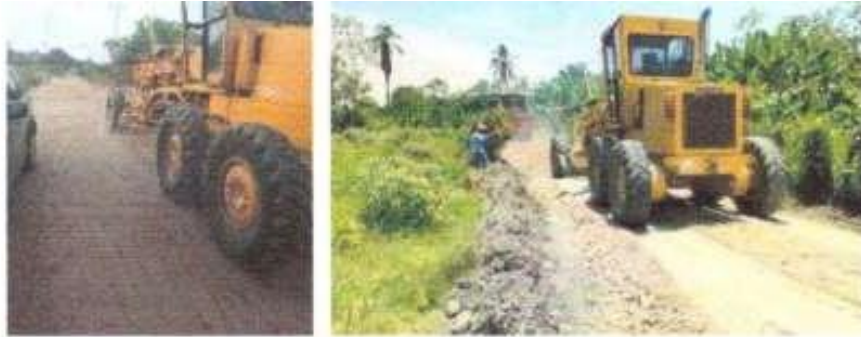
MAQUINARIA UTILIZADA EN OBRA - RETROEXCAVADORA
