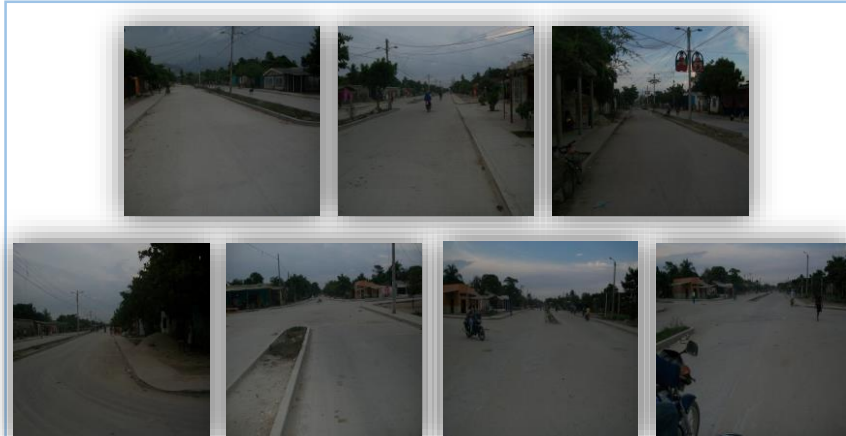
PAVIMENTACIÓN MASIVA DEL MUNICIPIO
