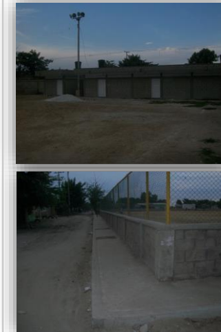
CONSTRUCCION DE CAMERINOS Y ANDEN PERIMETRAL CANCHA LA NEVADA
