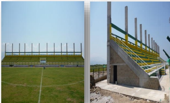
AMPLIACION DE GRADAS DEL ESTADIO DE FUTBOL EN LA UNIDAD DEPORTIVA
