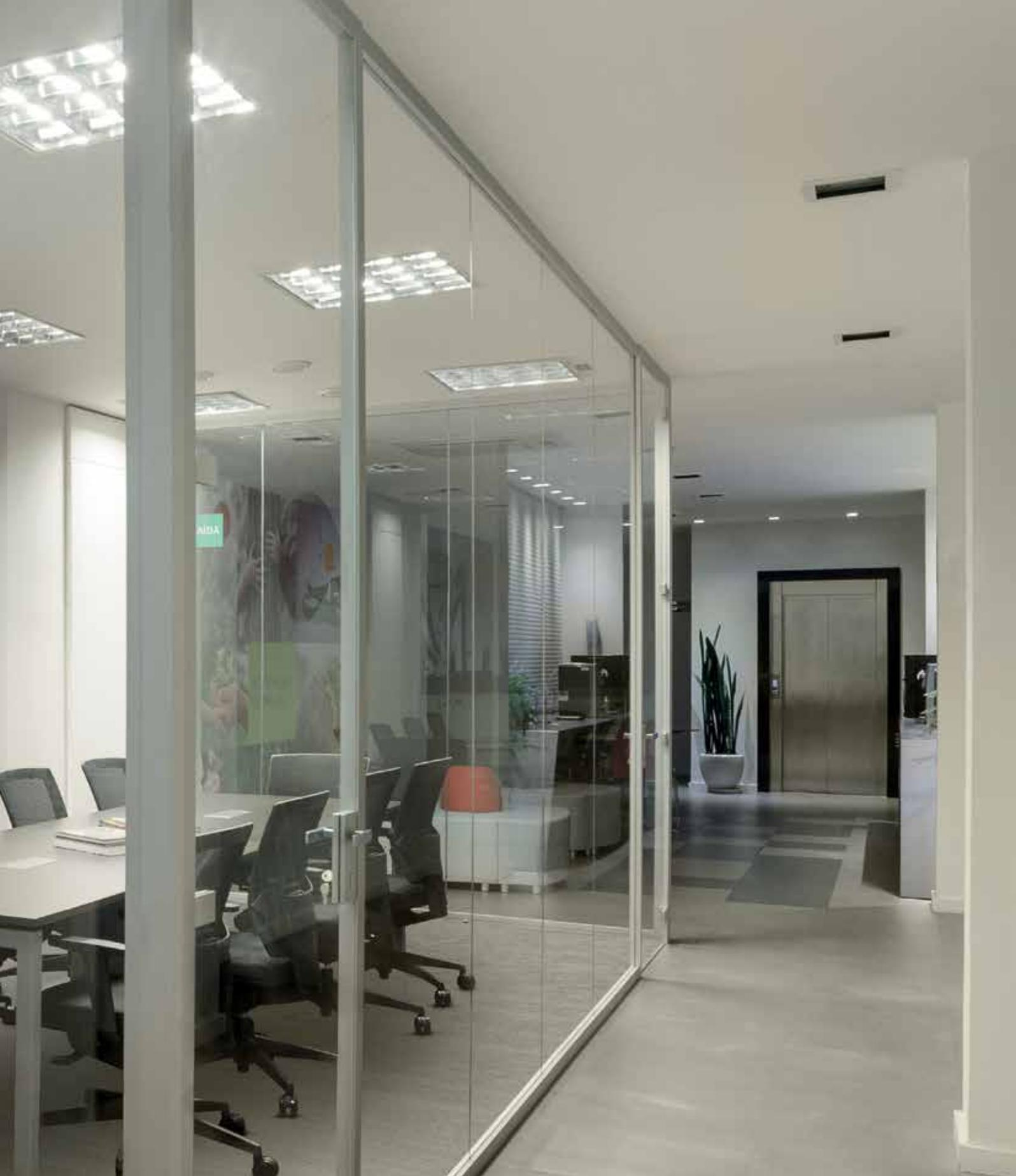
**Junta** seca com perfil de policarbonato.
